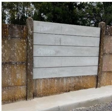
Mur d'enceinte du nouveau cimetière : des plaques neuves ont remplacé celles qui menaçaient de s'effondrer. Un caniveau a été aménagé pour faciliter l'écoulement des eaux pluviales et limiter la pousse d'herbe autour des caveaux.
