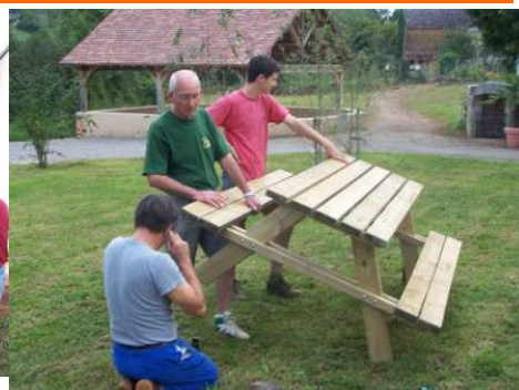
Mise en place des bancs
